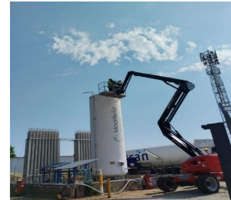
Trabajos de reparación de la envolvente exterior en el depósito de Talamanca de Jarama
