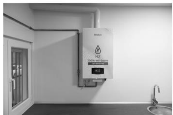
Imagen 57 Caldera instalada en las oficinas de Madrileña Red de Gas, preparada para consumir un 100% de hidrógeno
