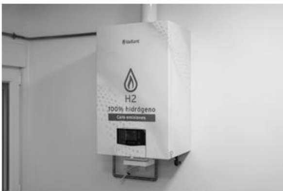
Imagen 57 Caldera instalada en las oficinas de Madrileña Red de Gas, preparada para consumir un 100% de hidrógeno
