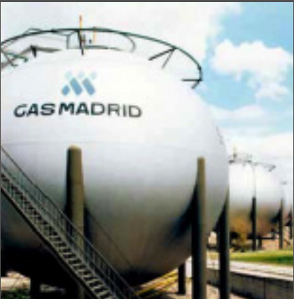
Nueva fábrica de Gas Madrid, en Manoteras (c. 1970).
